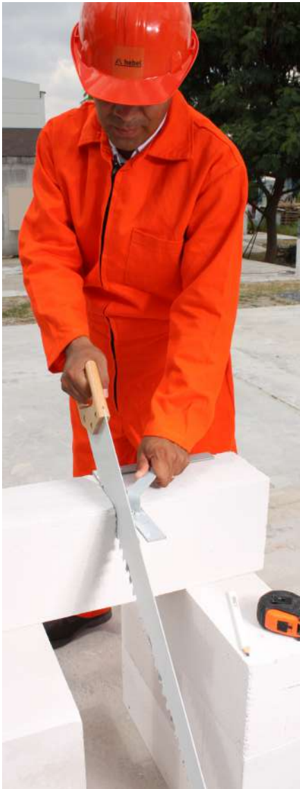
Fig. 16: Corte con serrucho y escuadra.
