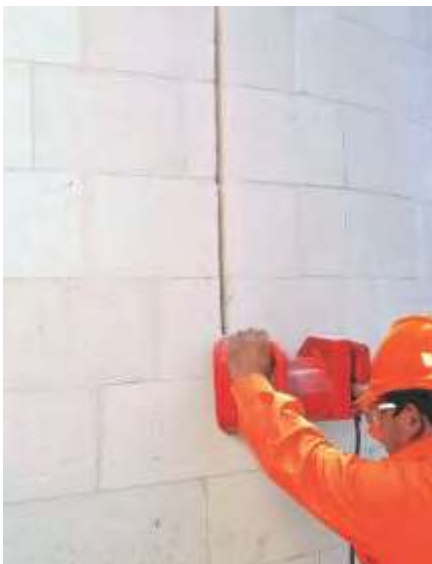
Fig. 25: Ranurador eléctrico Macroza.
