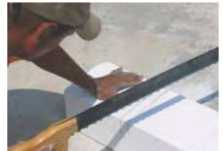
Fig. 22A: Corte con serrucho.
