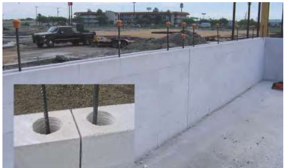
Fig. 17: Junta de control en muro.
