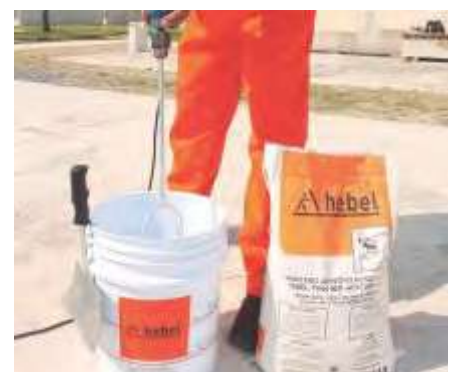
Fig. 6: Mezclado de Adhesivo Hebel.
