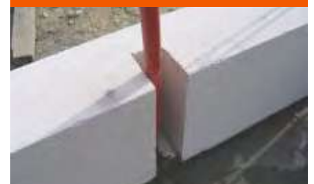
Fig. 22B: Resaque para tubería y mangueras.
