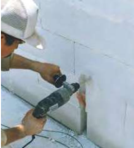
Fig. 24: Ranurador circular para contactos y salidas eléctricas.
