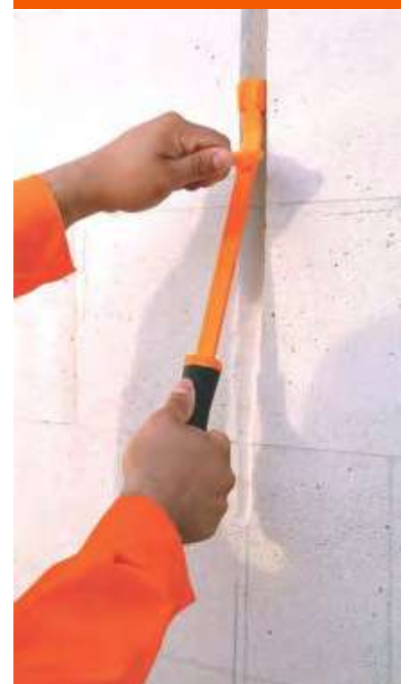
Fig. 22C: Ranurado para instalaciones de servicio.
