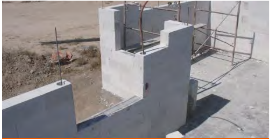
Fig. 26: Mampostería reforzada interiormente.
