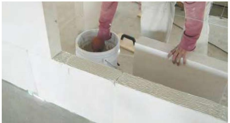
Fig. 8: Aplicación de Adhesivo Hebel.
