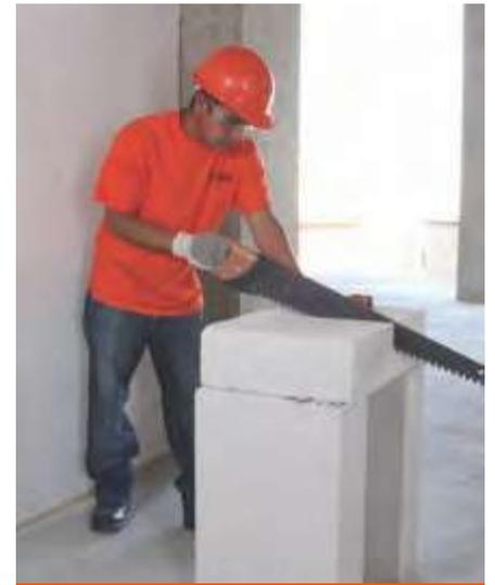
Fig. 9: Corte con serrucho Hebel.
